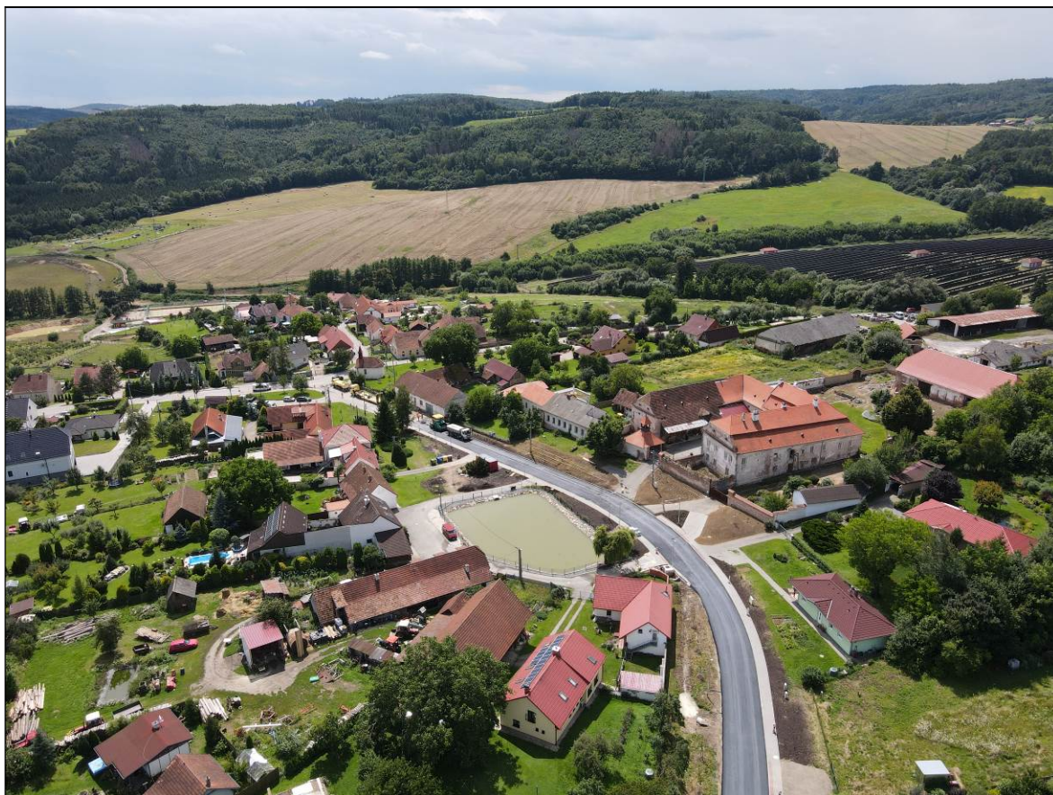
Realizace výsadeb podél nové silnice na Závist v okolí revitalizované požární nádrže.
