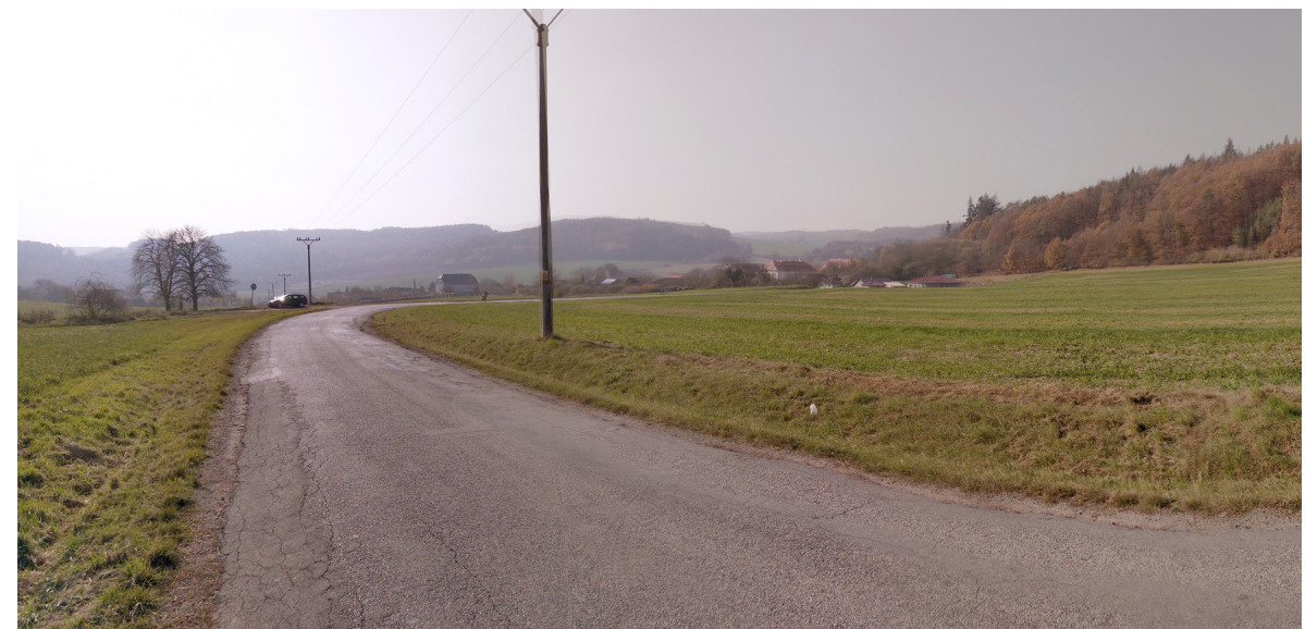
Stav lokality v r. 2021, pohled ze silnice od severu směrem k obci; úsek vzdušného vedení VN 22 kV je přeložen pod zem, vlevo dvojice jírovců při ohbí silnice
